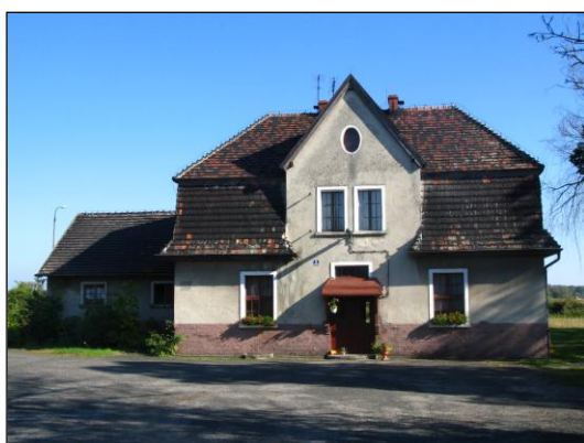
Rozmierka, budynek stacji kolejowej
