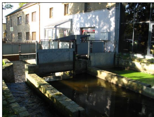
Kadłub, przepust wodny
