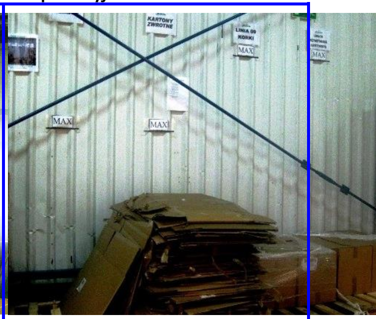
Foto 2: Rodzaj obudowy hali produkcyjnej
