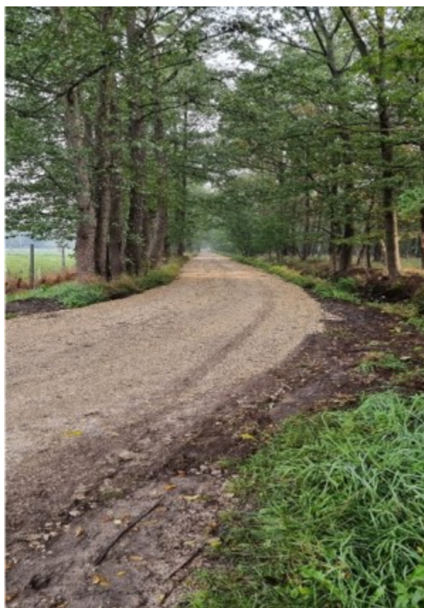
po wykonaniu remontu
