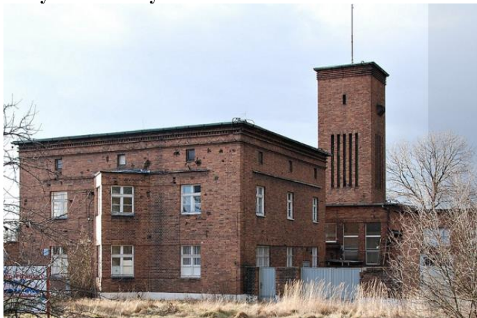
Zdjęcie nr 41. Budynek biurowy rzeźni w Strzelcach Opolskich
