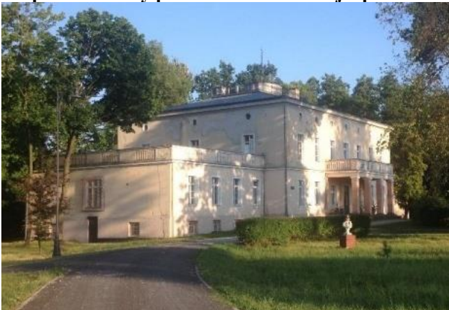
Zdjęcie nr 4. Pałac w zespole zabudowy pałacowo-folwarcznej z parkiem w Błotnicy Strzeleckiej
