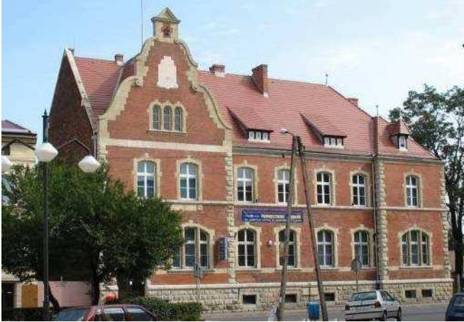
Zdjęcie nr 28. Budynek poczty, ul. Marka Prawego w Strzelcach Opolskich
