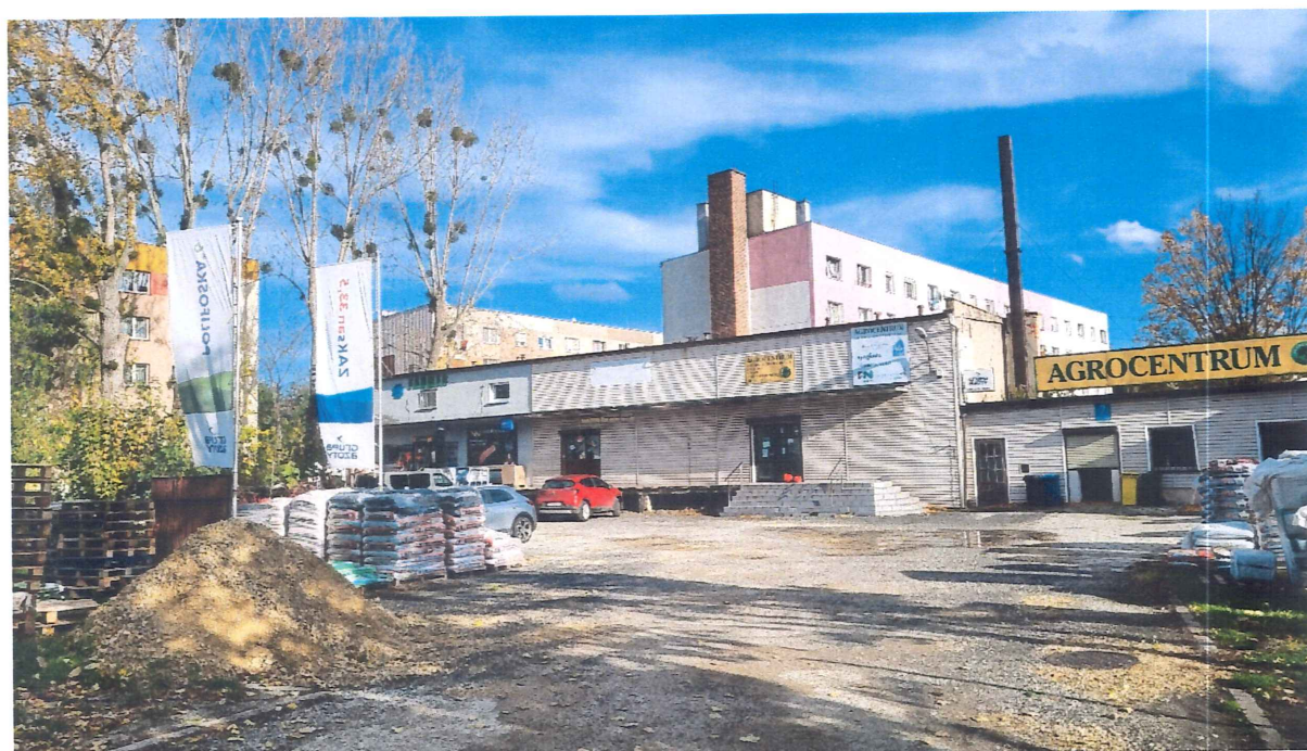
Fotografia 2. Istniejące zabudowania hurtowni rolniczej na działce nr ew. 1926/2.
