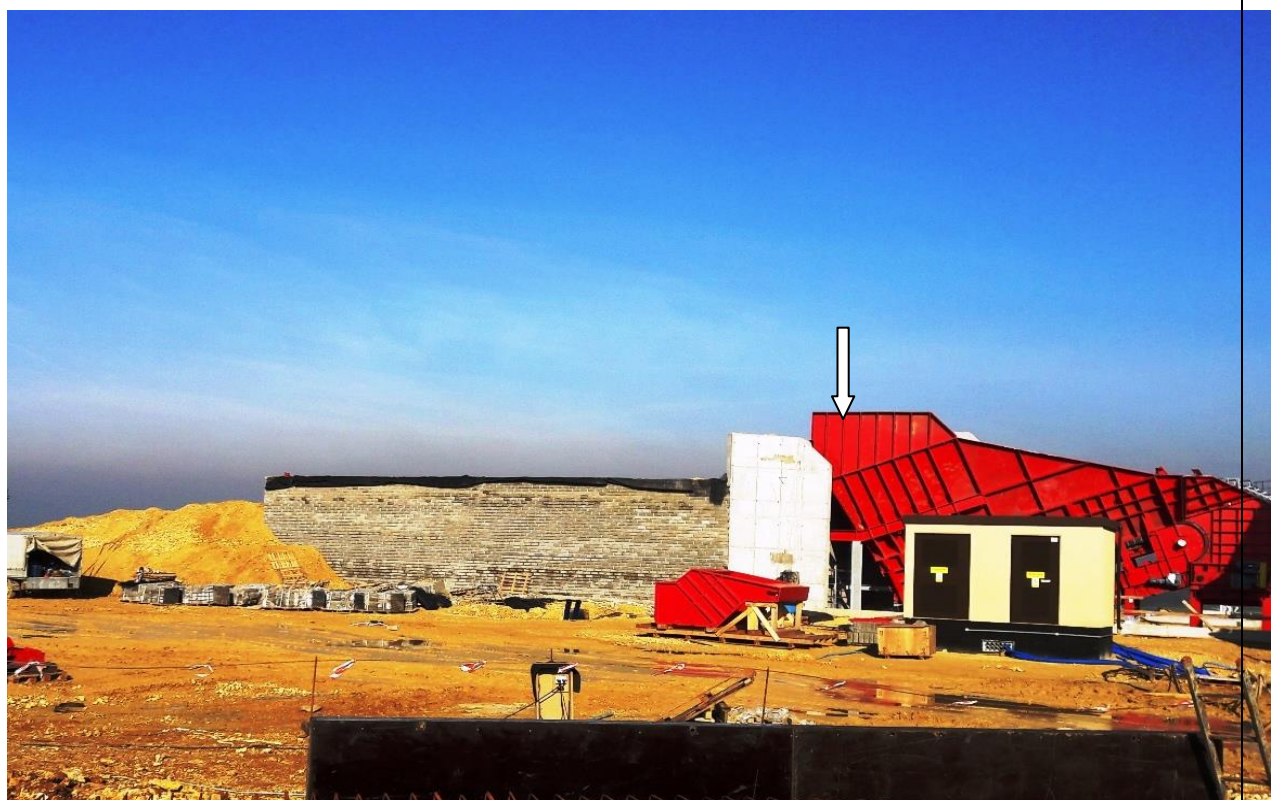
Foto 17: Zakład przeróbczy (w budowie): mur oporowy z najazdem, kosz zasypowy (strzałka), podajnik członowo-płytkowy, ruszt, wstępna kruszarka udarowa.
