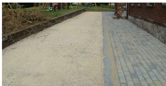
dojście do świetlicy po zakończeniu robót
