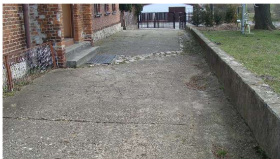
dojście do świetlicy przed rozpoczęciem robót
