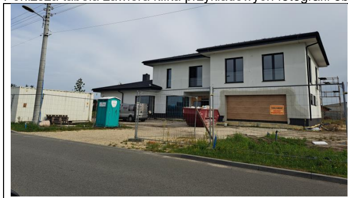
ul. Główna. Współczesna zabudowa mieszkaniowa jednorodzinna (w trakcie budowy).
