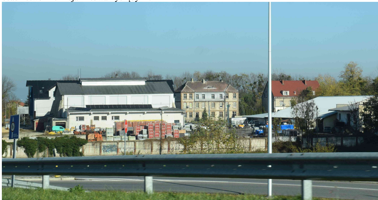
Widok z ul. Marka Prawego na tereny produkcyjne i magazynowe usytuowane na terenie 2U-P. W głębi widoczne dwa budynki wielorodzinne na terenie dawnych zakładów wapienniczych.
