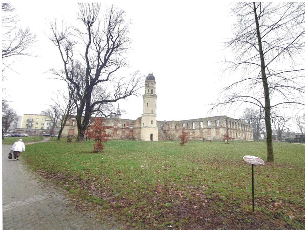
FOT.1. WIDOK NA ZAMEK OD STRONY POŁUDNIOWO-ZACHODNIEJ.
