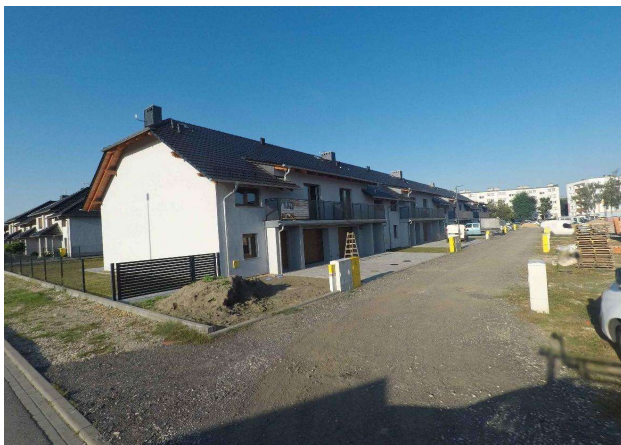
Przebudowa drogi ul. Ogrodowej w Strzelcach Opolskich
