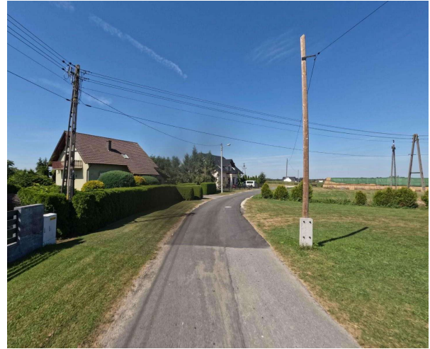
Odwodnienie drogi gminnej nr 105361 O ul. Leśnej w Rożniątowie
