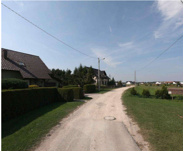
Przebudowa ul. Stawowej w Grodzisku
