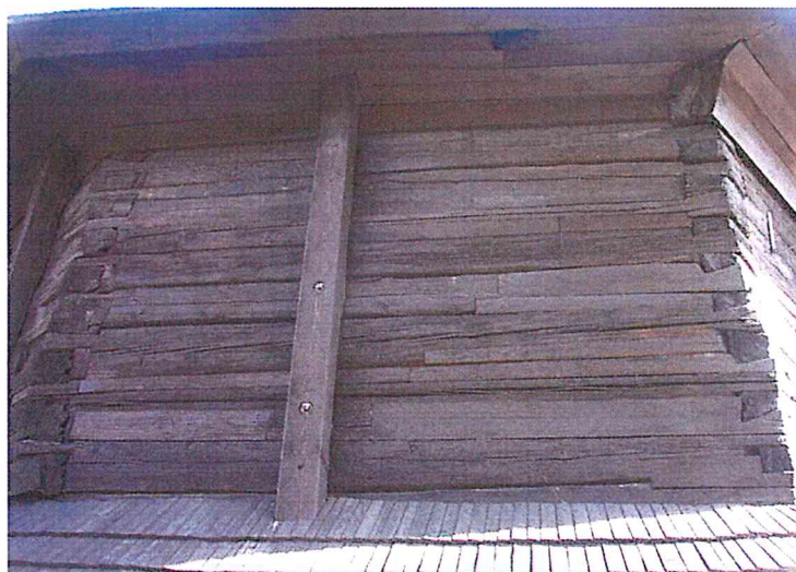
Fot.3. Część górna, prawa – elewacja frontowa, połudn-zachodnia.
