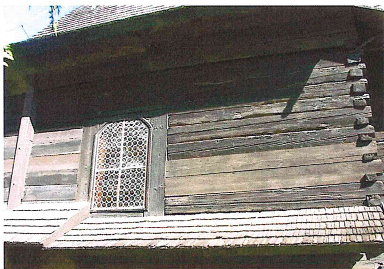
Fot.14. Wstawki na belkach ściennych prezbiterium – część górna, strona południowa
