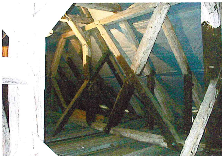
Fot.24. Impregnacje elementów stężeń krzyżowych i słupków wsporczych krokwi
