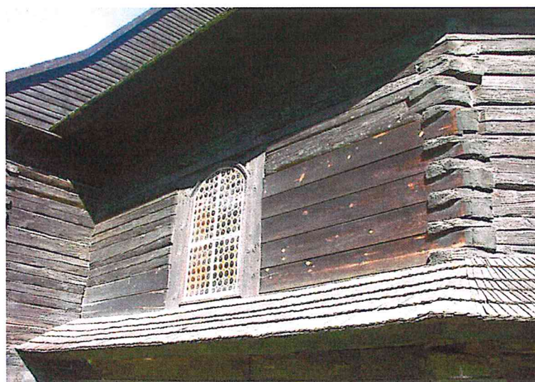
Fot.12. Wstawki na belkach ściennych prezbiterium – część górna, strona południowa
