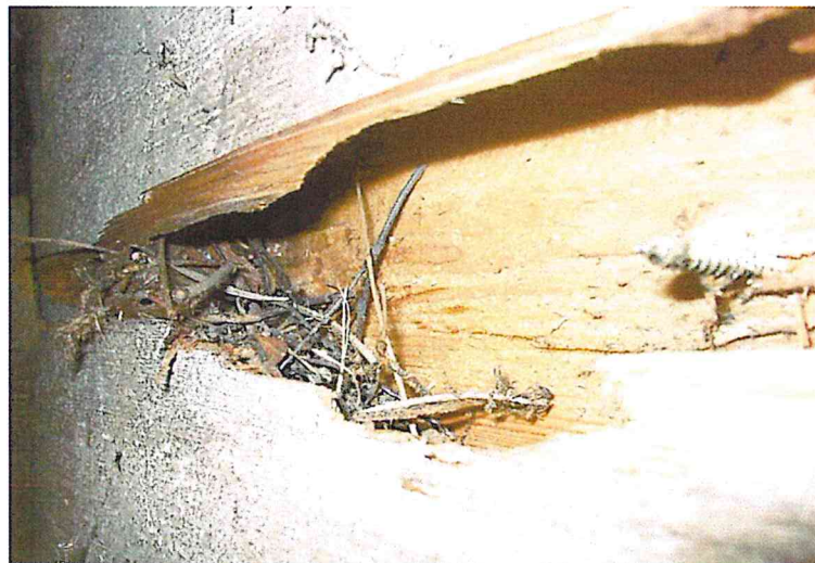
Fot.26. Odkrywka nr1 – powiększenie, zmurszałe wewnątrz belki, resztki gniazda
