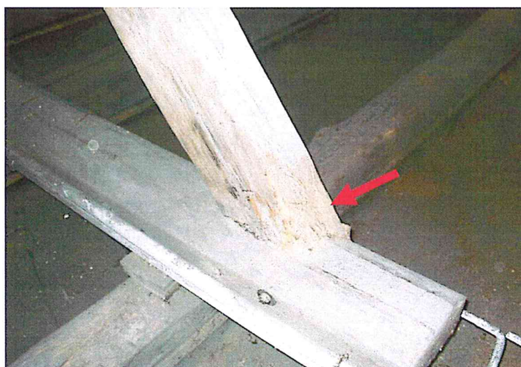
Fot.21. Zmurszała podstawa zastrzału stężenia podłużnego
