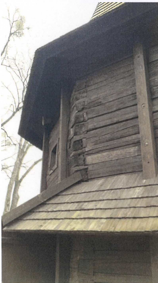
Wybrzuszenia ścian i odchylenia związane z nierównomiernym osiadaniem
