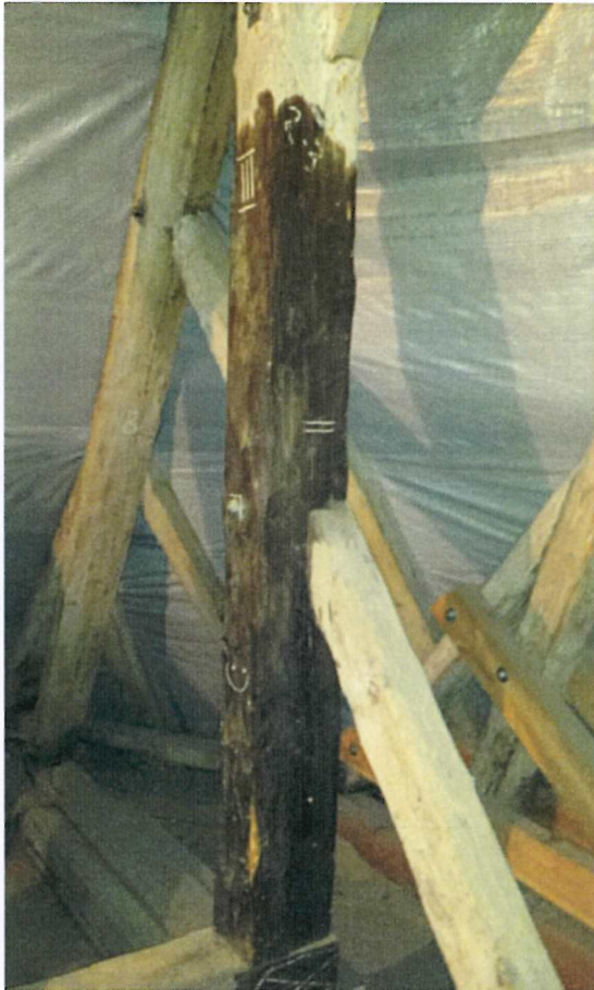
Impregnowane środkami olejowymi fragmenty konstrukcji więźby dachowej
