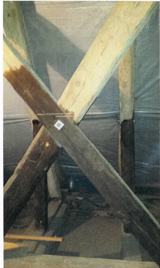
Impregnowane środkami olejowymi fragmenty konstrukcji więźby dachowej
