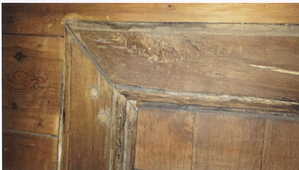
wymyty impregnat ze ściany zrębowej ścianę kościoła
