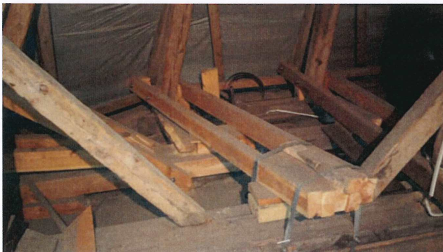
Wtórne wzmocnienia belek podwalinowych
