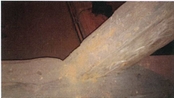
Korozja biologiczna drewna więźby dachowej
