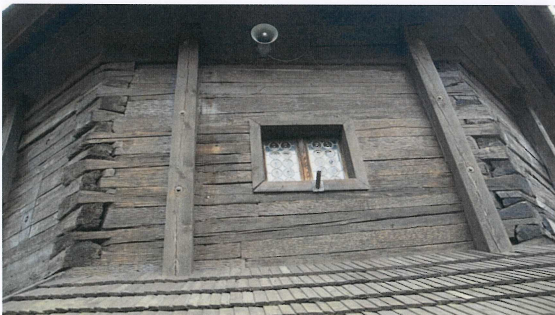
Lisice wzmacniające ściany wieńcowe
