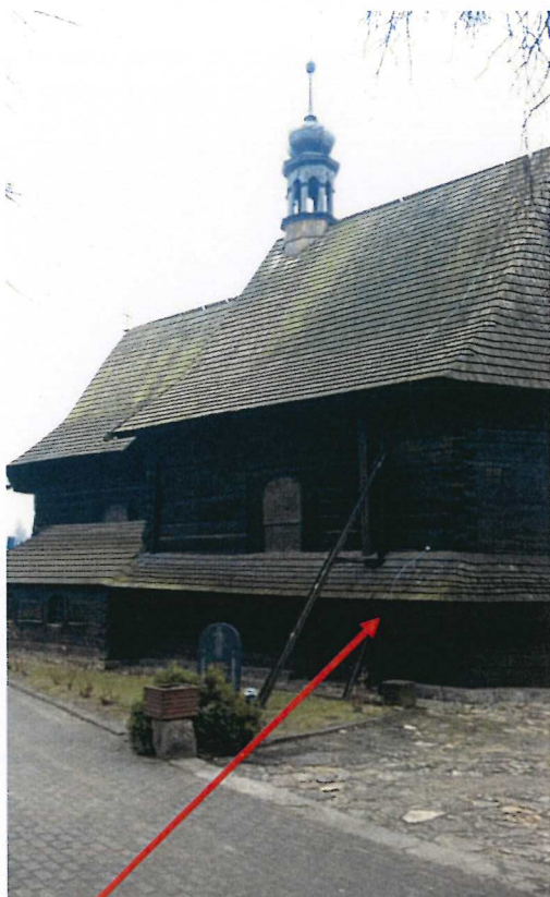
Podparcie stabilizujące osiadającą
