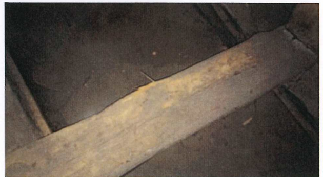
Korozja biologiczna drewna więźby dachowej
