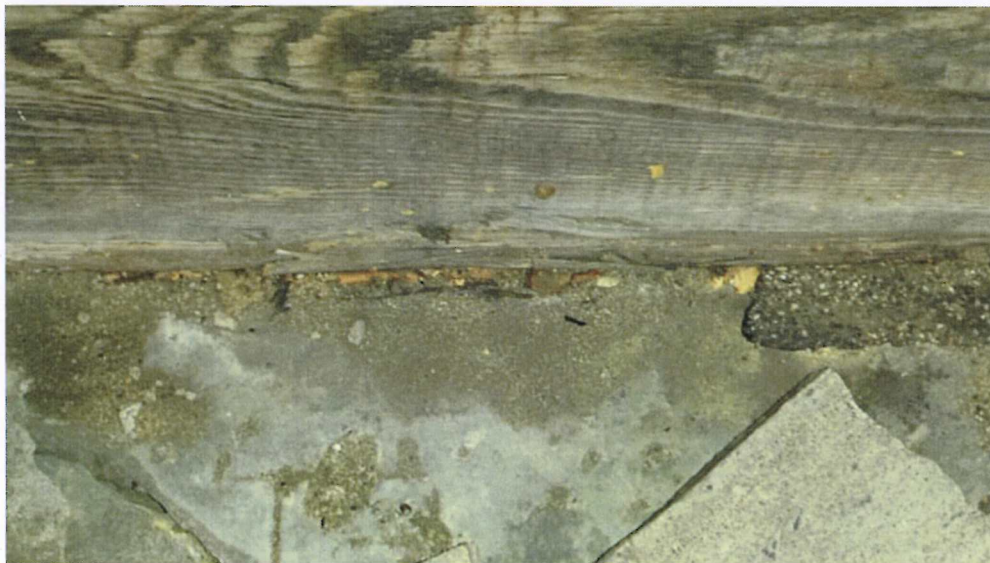
Mało skuteczna izolacja pionowa, brak izolacji pod belką podwalinową
