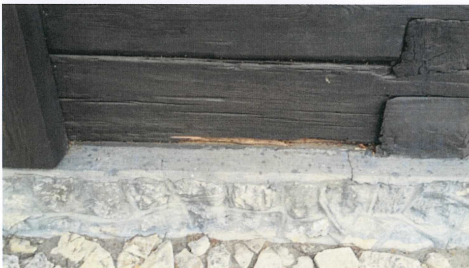
otwory wlotowe i ślady żerowania
