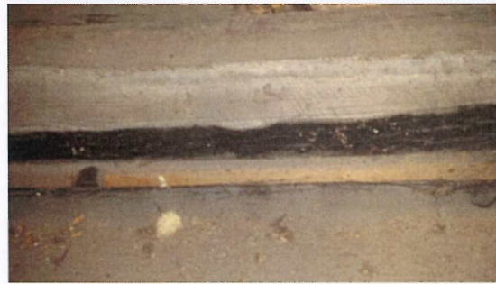
Otwory wylotowe- czynne żerowiska Spuszczela pospolitego ( Hylotrupes bajulus )
