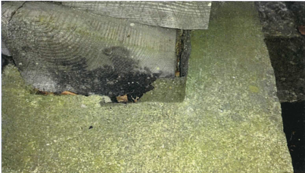
Mało skuteczna izolacja pionowa, brak izolacji pod belką podwalinową
