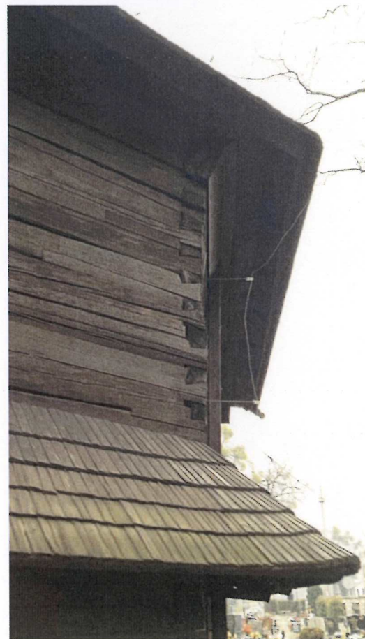
Wybrzuszenia ścian i odchylenia związane z nierównomiernym osiadaniem
