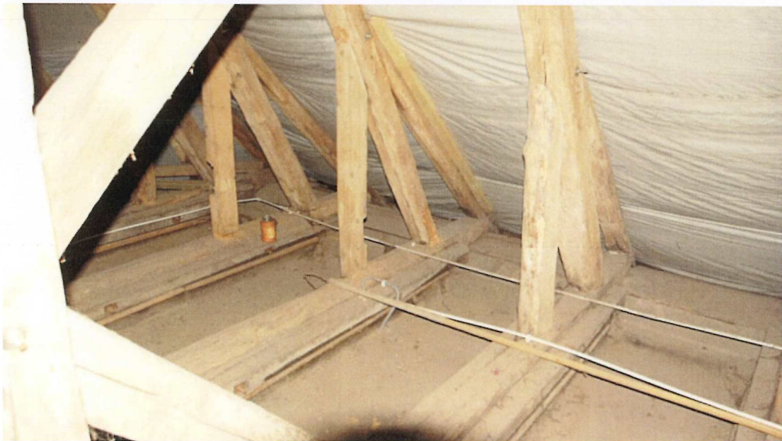
Obustronne wzmocnienia belek stropowych.
