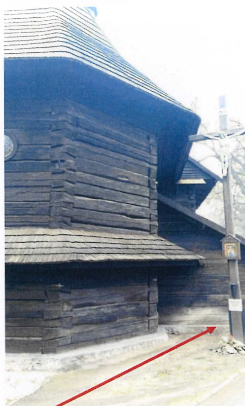
wymyty impregnat ze ściany zrębowej ścianę kościoła
