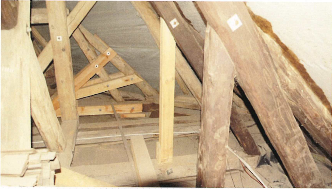
Widoczne nowe elementy więzby dachowej
