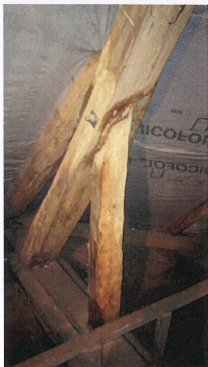
Grzyb domowy właściwy i Spuszczel pospolity
