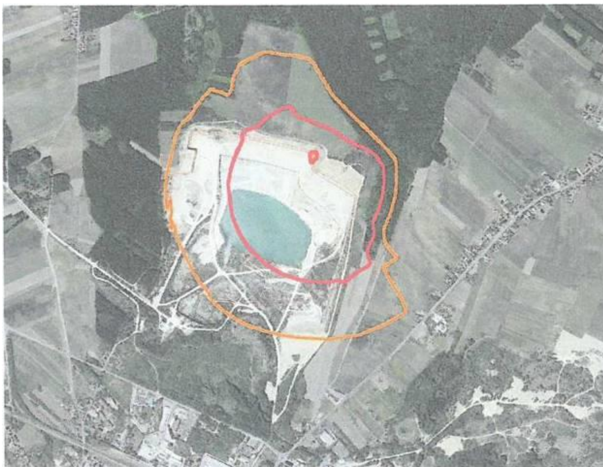
Ryc. 14 Scenariusz II: praca zespołu koparka - kruszarka - przesiewacz - ładowarka przez 50% czasu odniesienia, t.j. przez 4 godziny w czasie zmiany roboczej
