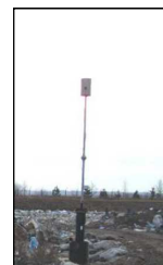
Fot. Zrehabilitowana kwatera składowiska oraz pochodnia na eksploatowanej kwaterze
