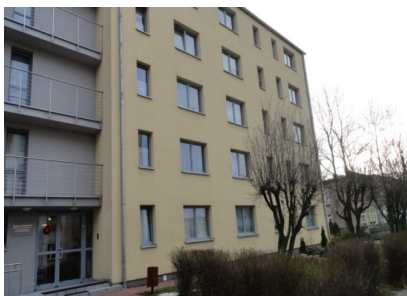
Budynek w którym usytuowane są mieszkania chronione.
