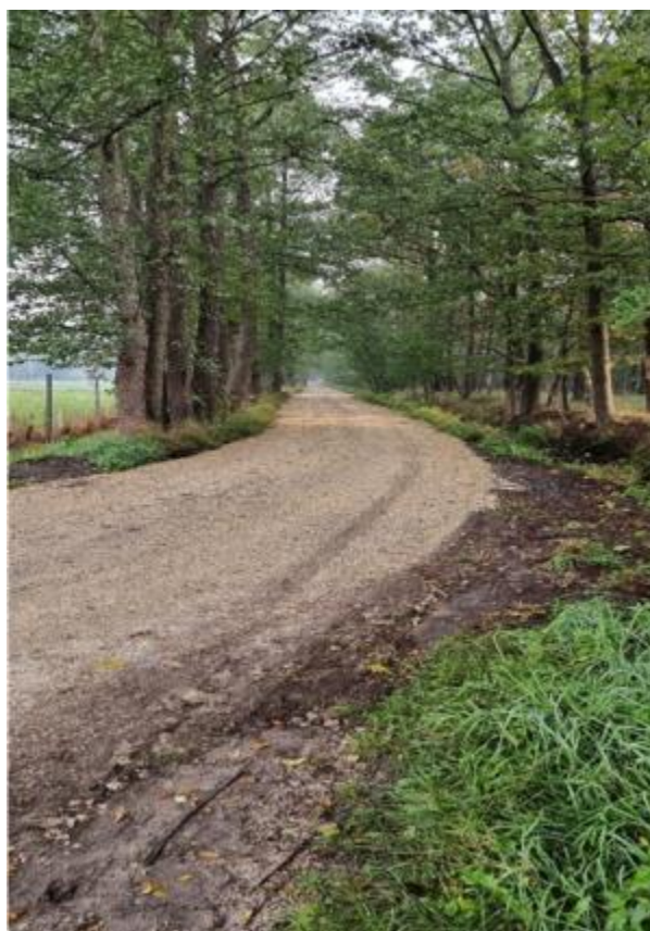
po wykonaniu remontu
