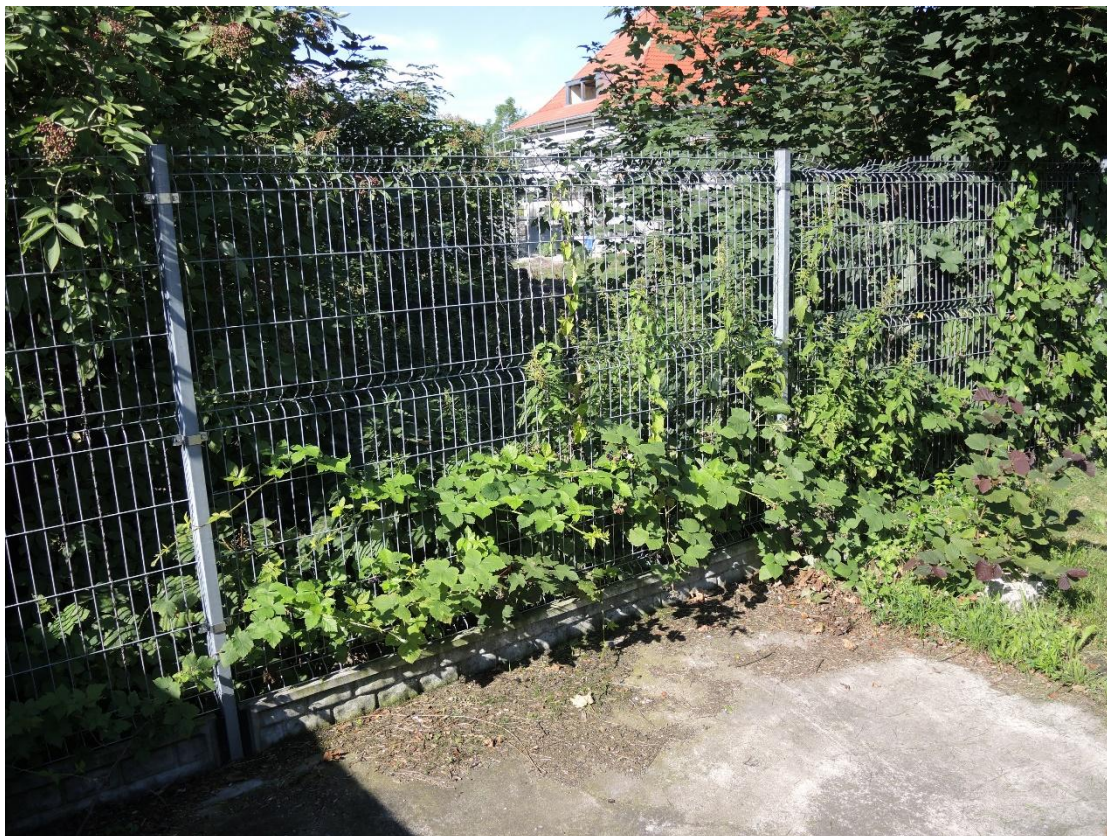
Zdj. 4. Istniejący ogrodzenie panelowe z cokolikiem na granicy przedszkola i terenu prokuratury (częściowo do rozbiórki).
