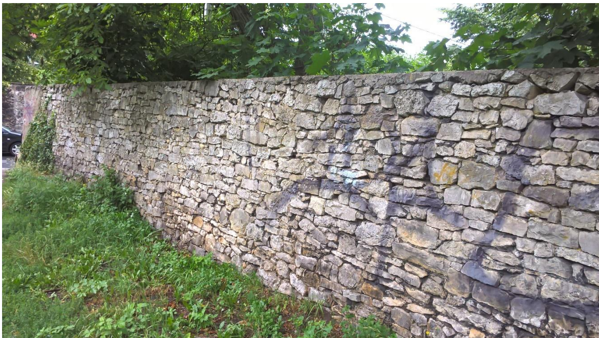
Zdj. 2. Istniejący mur z kamienia wapiennego od strony ulicy Kościuszki (do rozbiórki).
