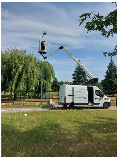
Prace przy wymianie oświetlenia na parkingu cmentarza
