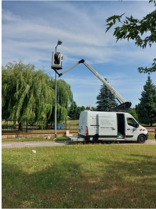
Prace przy wymianie oświetlenia na parkingu cmentarza
